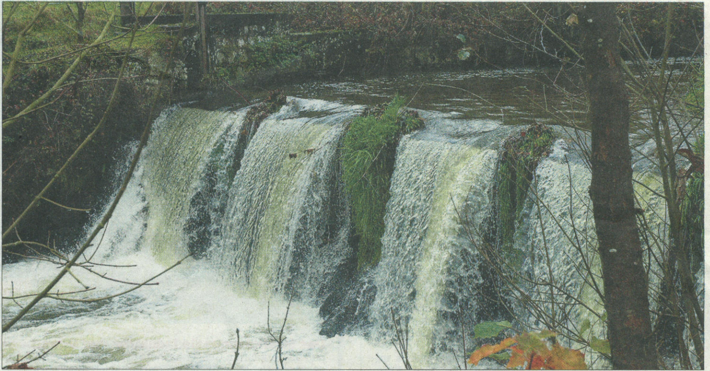
Das Wasser des Harmersbachs, das jetzt noch beim »Geisteichwehr« herunterstürzt, könnte nach Plänen der Bürger-Energiegenossenschaft E-Werk Mittelbaden einmal eine Wasserkraftanlage betreiben.
